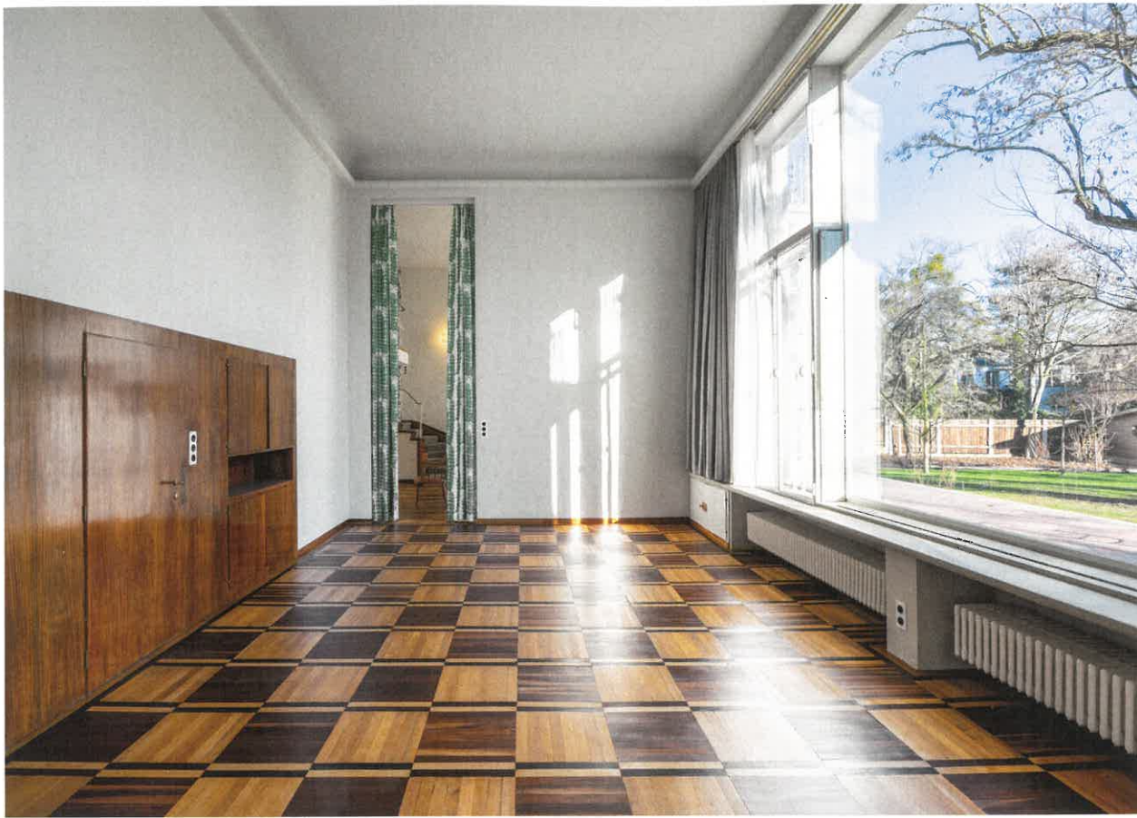
SPEISEZIMMER Das aufwendige Schachbrettmuster des Bodens setzt sich aus vier Hölzern zusammen: Mahagoni, Ahorn, Palisander und Eiche. Die unauffällige Tür links führt in die Küche
